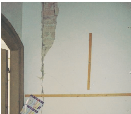
Figura 16. muratura in mattoni pieni (tipo 6)
