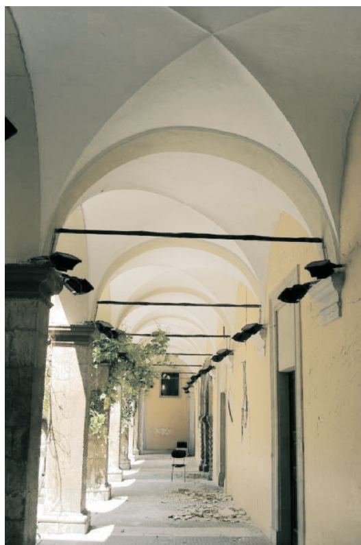
Figura 9. Volte a crociera del piano terra (solaio tipo 2)
