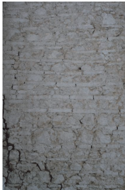
Figura 14. muratura in blocchi di pietra squadri – pilastrata chiostro (tipo 5)
